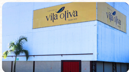
Centro de Distribuição
